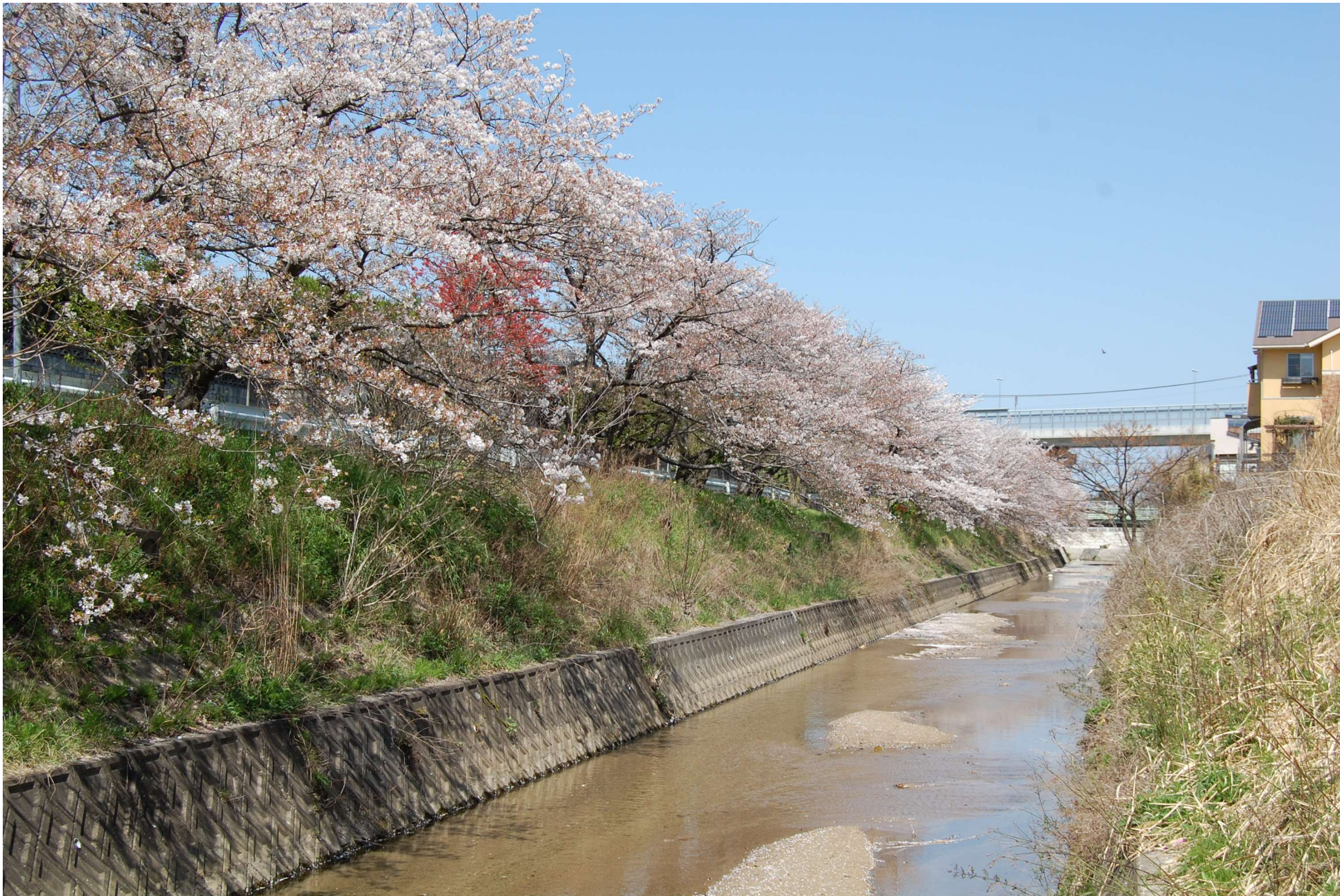
二級河川 樋井川（城南区樋井川）
