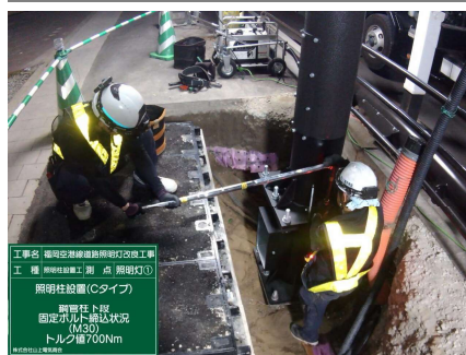
②ファスト柱(照明灯)の設置
