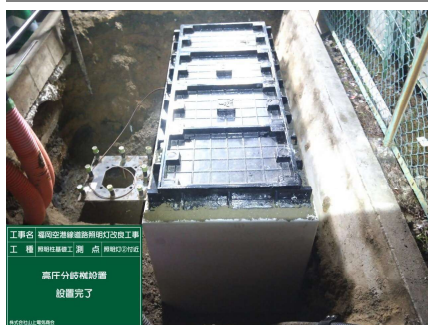
①照明灯基礎と高圧分岐桝の設置
