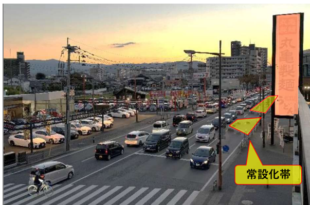
工事箇所(全景)
