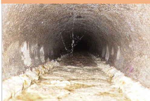
下水道管へ流出した油脂
