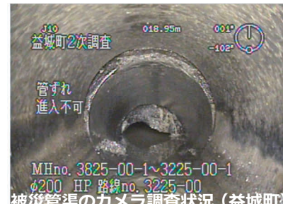
被災管渠のカメラ調査状況(益城町)
