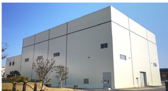
▲下水汚泥固形燃料化施設外観
