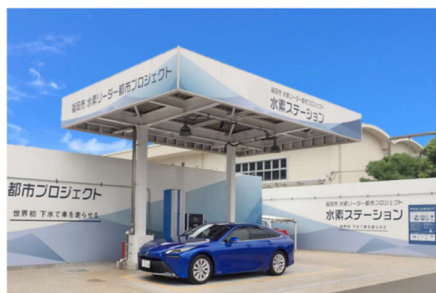
▲下水から水素をつくる 世界初の水素ステーション
