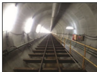
雨水管（内径約 5m）
