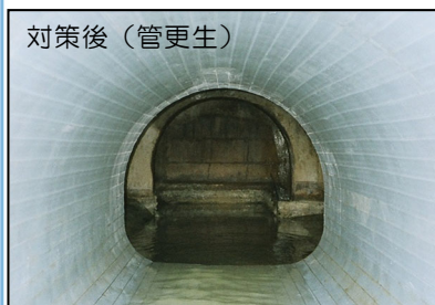
対策後（管更生）
