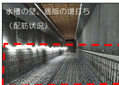
水槽の壁、底版の増打ち （配筋状況）
