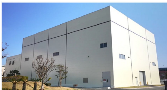
▲下水汚泥固形燃料化施設外観
