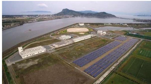
新西部水処理センターでは、流入ポンプ棟の上部に太陽光発電設備を設置し、発電を行っている。発電した電力は、場内利用している。
