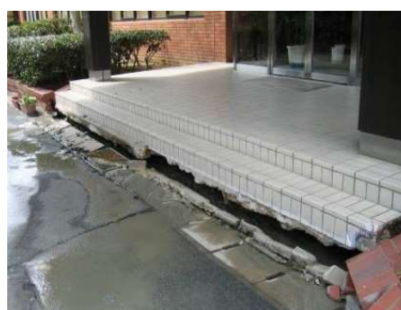
液状化で沈下した西戸崎水処理センター (福岡県西方沖地震)
