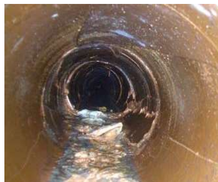
地震により被災した福岡市内の管渠
