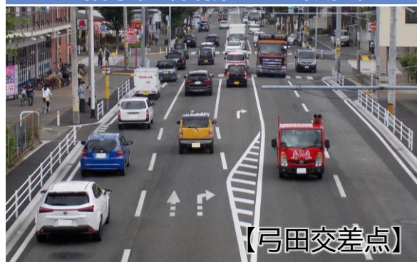
整備事例(右折レーン設置)
