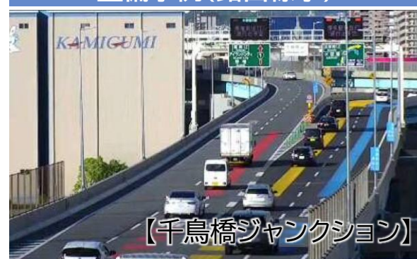
整備事例(路面標示)
