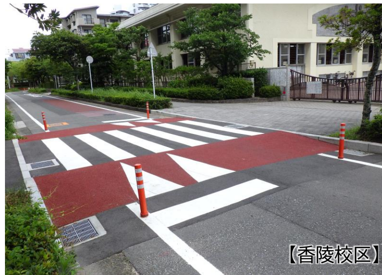
整備事例(スムーズ横断歩道)
