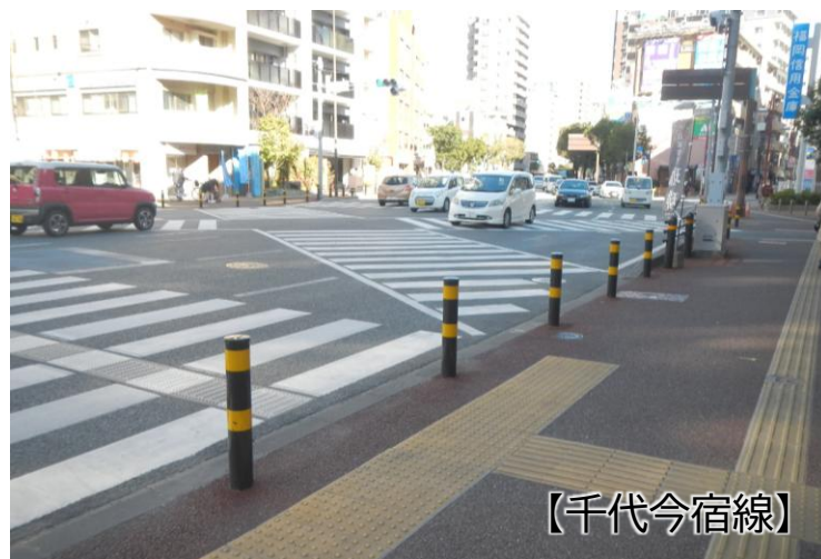
整備事例（防護柵・車止め）
