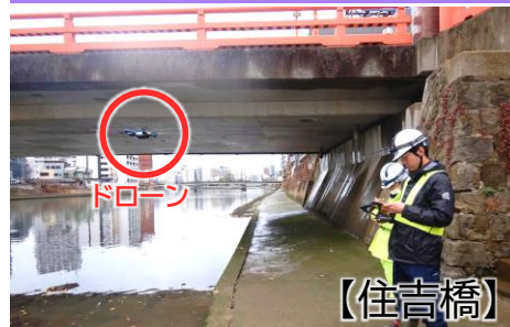
点検事例(ドローンの活用)
