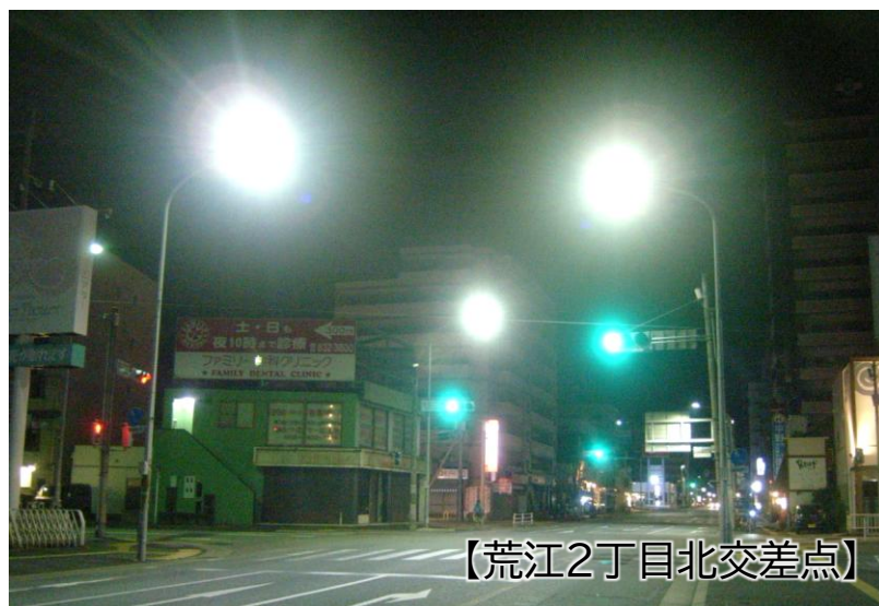
整備事例(道路照明灯LED化)
