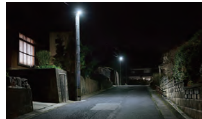
LED 防犯灯の設置例
