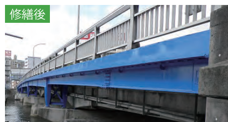
橋梁の修繕状況
