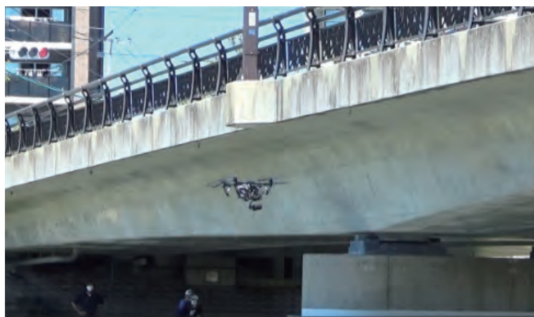
ドローンを活用した橋梁の点検状況
