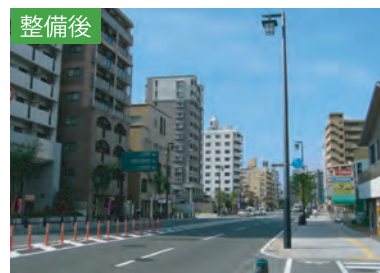
無電柱化〔都市計画道路 堅粕箱崎線〕
