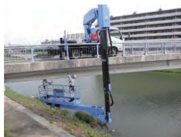
橋梁の点検状況
