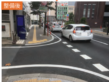
バリアフリー化された歩道
