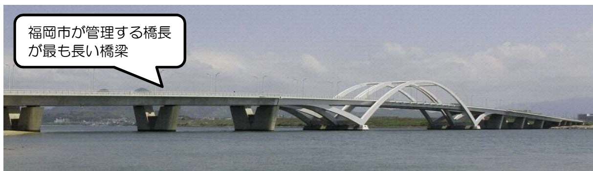
写真 3-1 海の中道大橋（橋長 750m）
