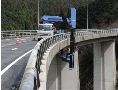
（橋梁点検車を使用）
