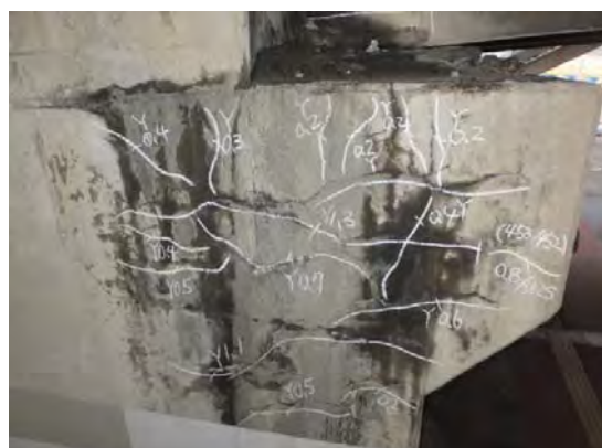
橋台の桁受け部
