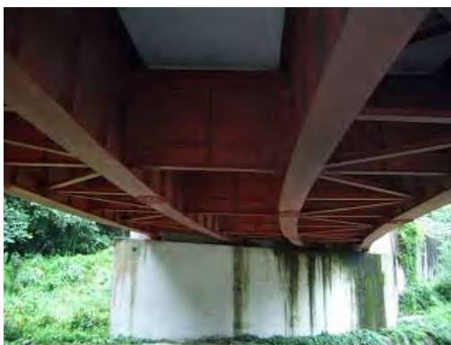
写真 3-1 I 桁橋 上部工
