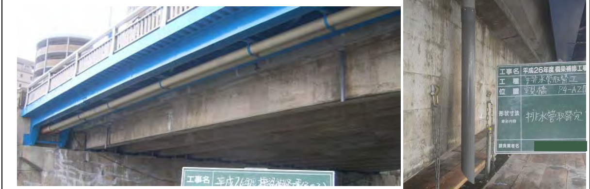
排水管垂れ流し部流末処理の例
