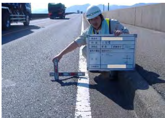
写真 7-2 路面の凹凸の変状事例
