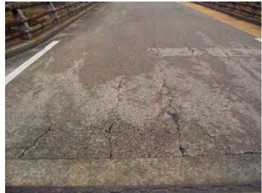
写真 7-1 舗装ひび割れの変状事例
