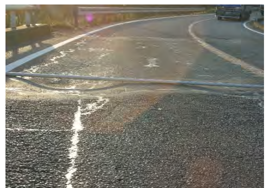
写真 7-2 路面の凹凸の変状事例
