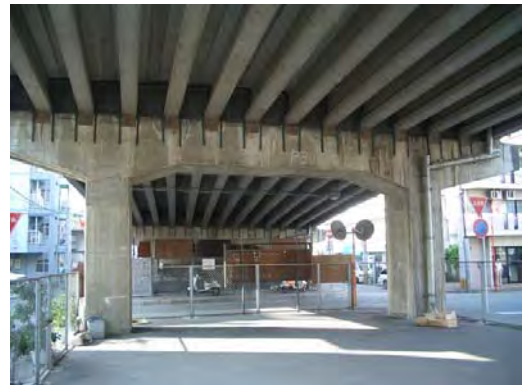
写真 3-9 ラーメン式橋脚
