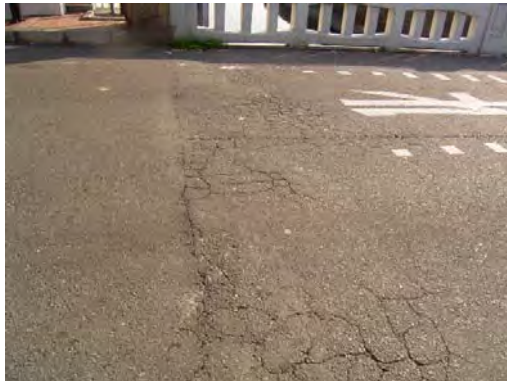
写真 7-1 舗装ひび割れの変状事例
