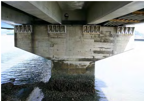
写真 3-8 T 形式橋脚
