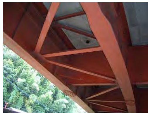
写真 3-1 I 桁橋 上部工
