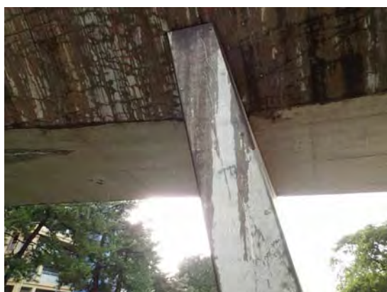
床版側面部、ラーメン橋脚
