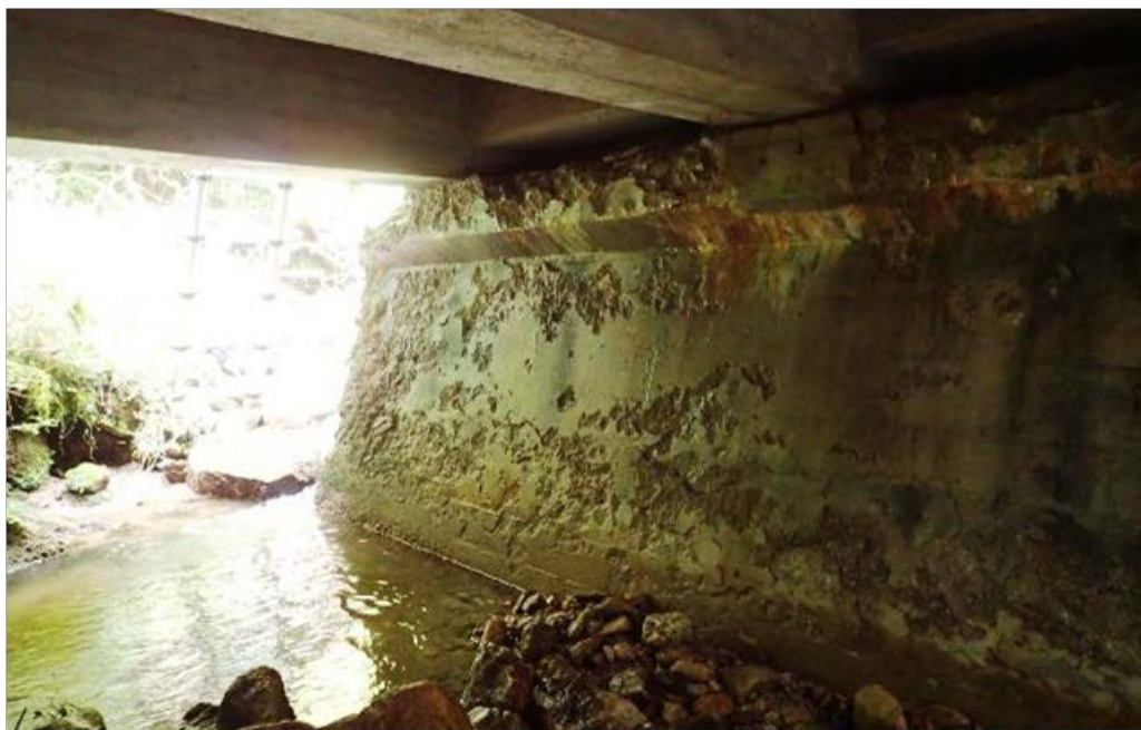
写真 3-4-3 南向き橋台（河川による水掛かり）
