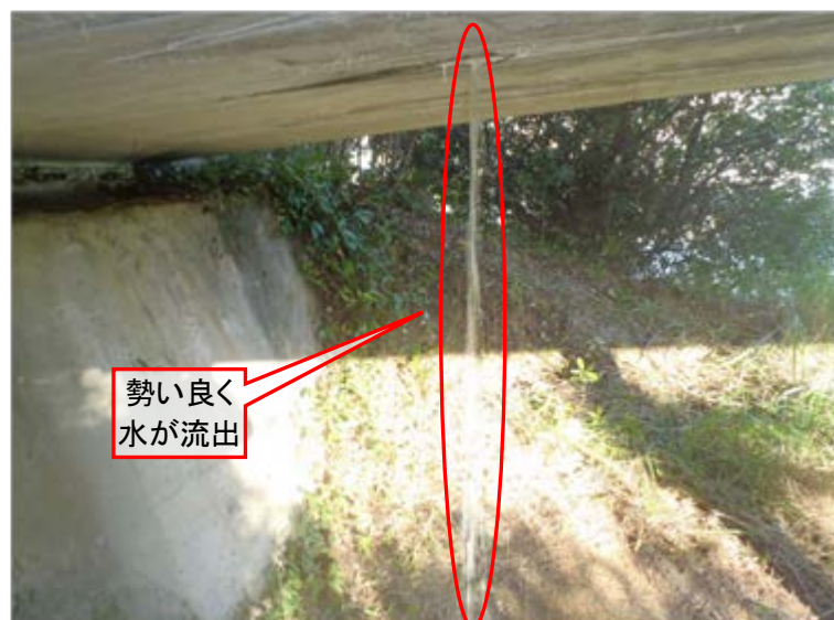
写真 3-3-6 ボイドからの水抜き状況 【PCボステン中空床版橋】
