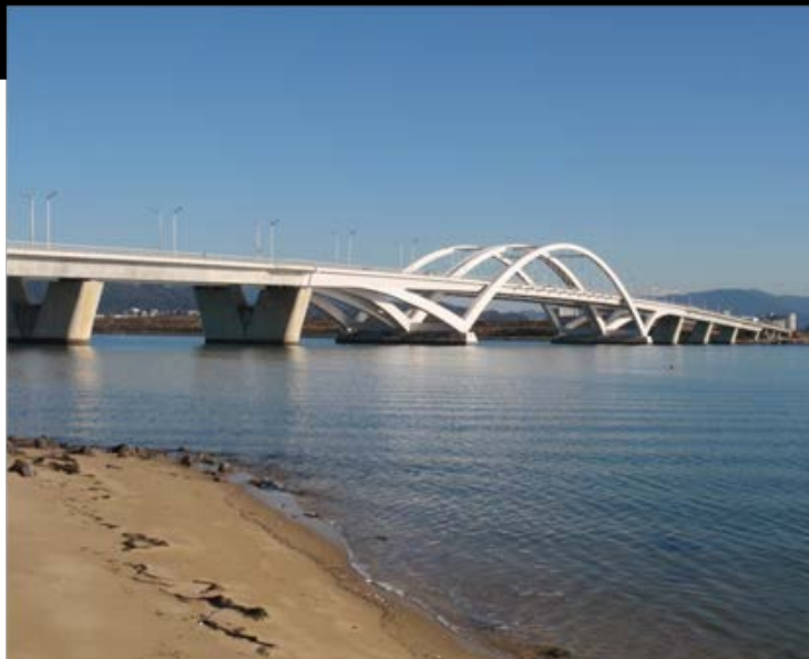
海の中道大橋 (3径間連続鋼バランスドアーチ橋他) 福岡市で一番長い橋:橋長 750m
