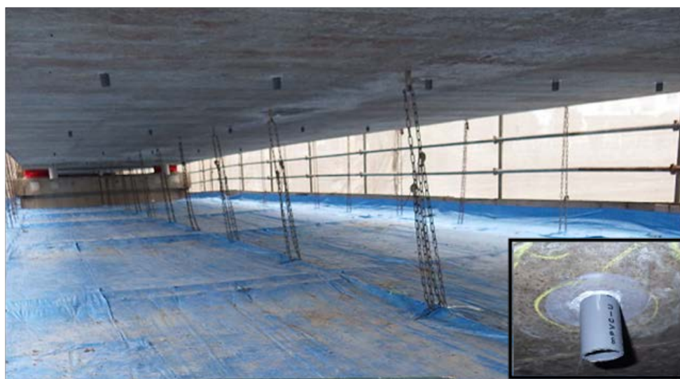
写真 3-3-12 管設置完了（PCポステン中空床版橋）
