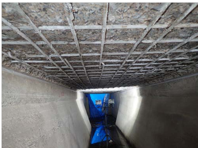
写真 3-2-2 全断面修復工（はつり完了）
