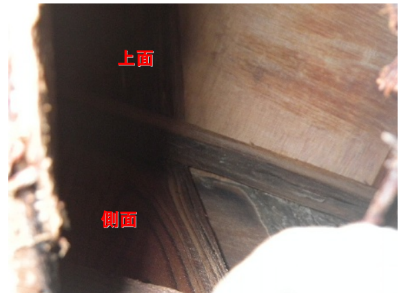
写真 4-1-3 ベニヤ板による中空内部 （下面から撮影）
