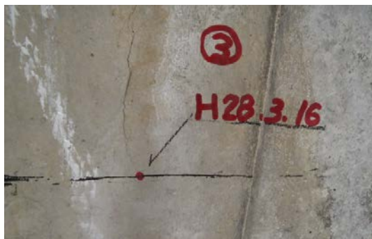
【ひび割れ端部墨入れ状況】
