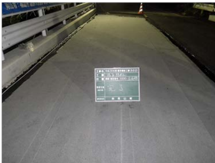
写真 3-1-4 橋面防水工（シート系）
