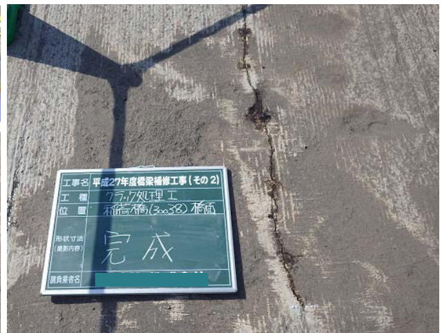
写真 3-3-16 桁の上面のひび割れ注入完了
