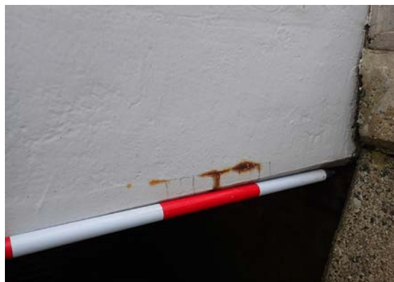
写真 4-2-4 表面被覆工の紫外線による再劣化【事例】
