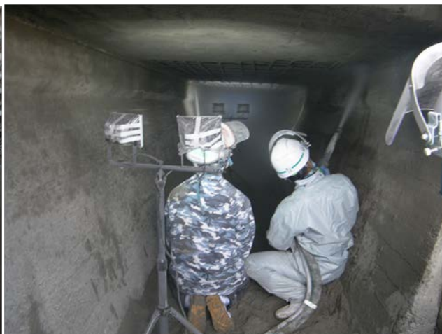
写真 3-2-3 全断面修復工（乾式吹付け状況）
