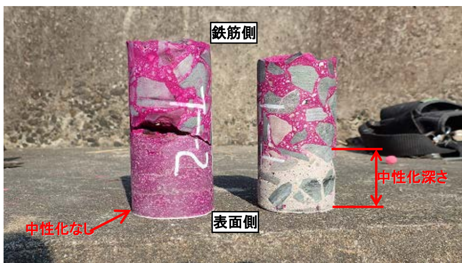
写真 3-1-2 中性化測定事例（コア法）
