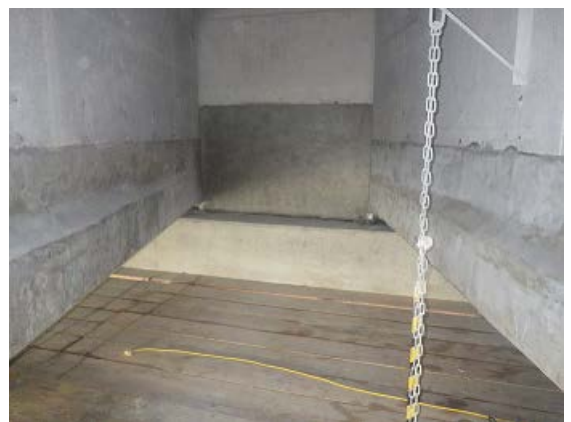
写真 3-2-7 断面修復完了
