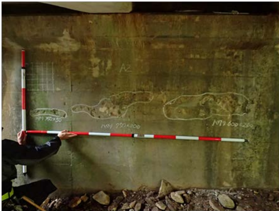
写真 3-4-5 北向き橋台（ポップアウト）
