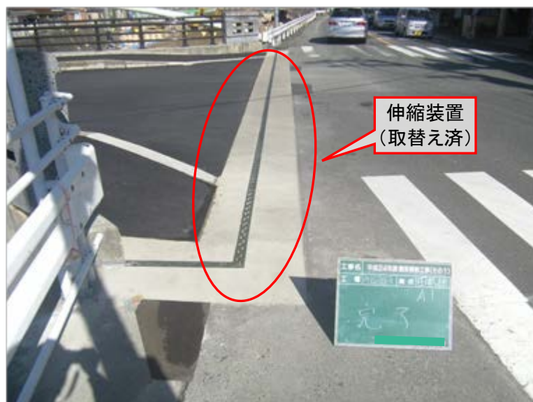
写真 3-1-6 伸縮装置取替え工（突合せジョイント）
