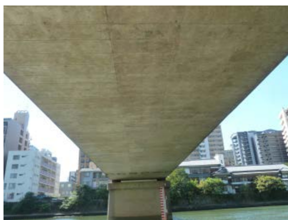
写真 3-1-14 桁下無対策の例（P Cポステン中空床版橋）
