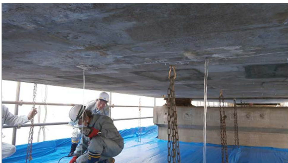
写真 3-3-11 小径削孔による位置出し状況（PCポステン中空床版橋）
