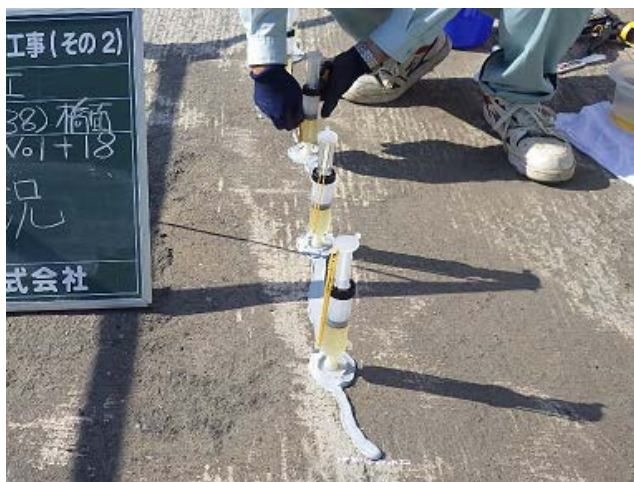
写真 3-3-15 桁の上面のひび割れ注入状況
