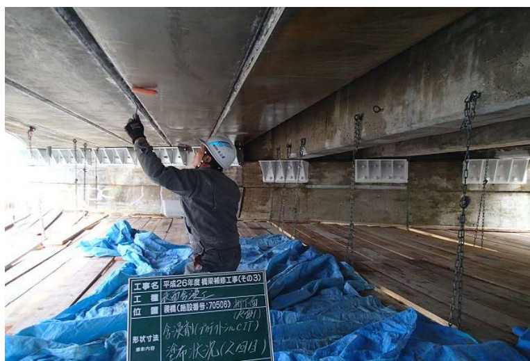
写真 3-1-13 表面含浸工の例（ホロー形式）
