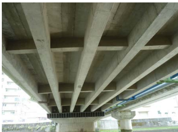
写真 3-1-15 桁下無対策の例（P CポステンT桁橋）
