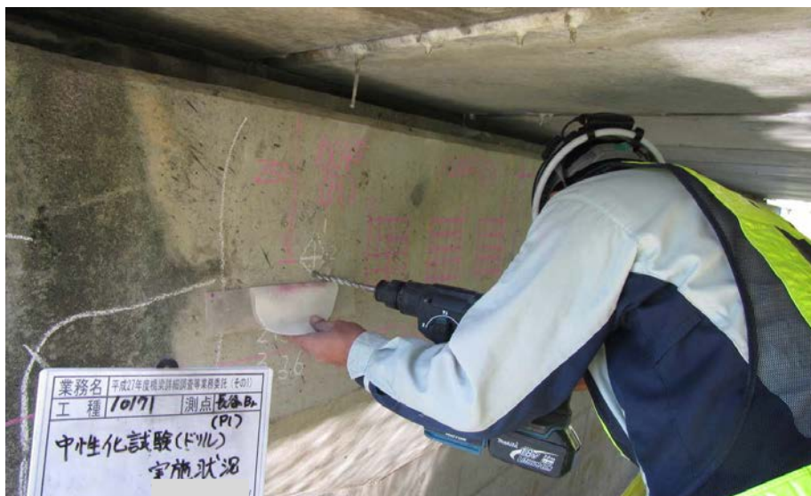
写真 3-1-1 中性化測定事例（ドリル法）
