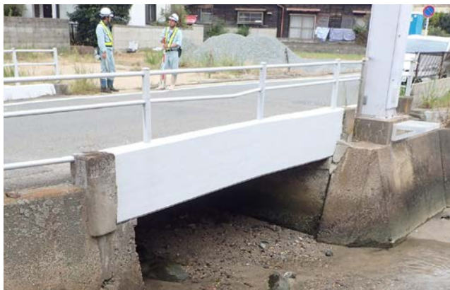
写真 4-2-4 表面被覆工の紫外線による再劣化【事例】
