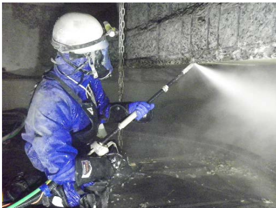
写真 3-2-4 はつり状況（ウォータージェット）
