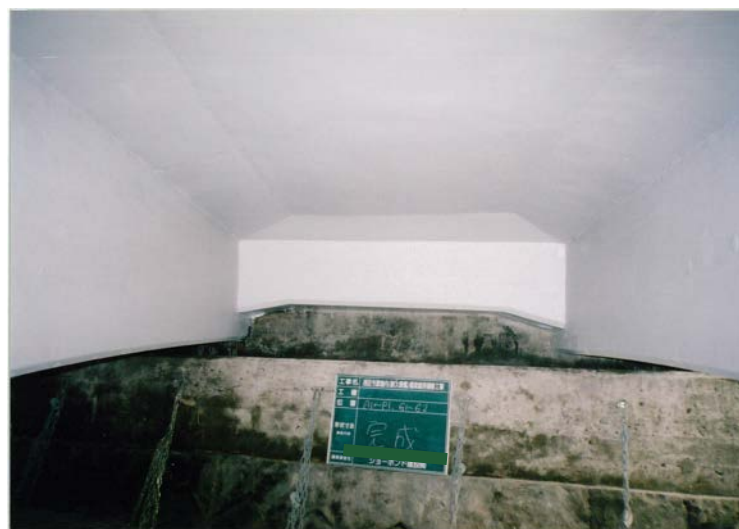
写真 3-1-12 表面被覆工の例（RCT桁橋）
