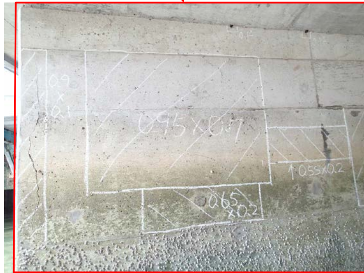
写真 3-1-9 干満の影響を受けた劣化事例<その3>【ラーメン橋脚(うき)】チョーク斜線部
