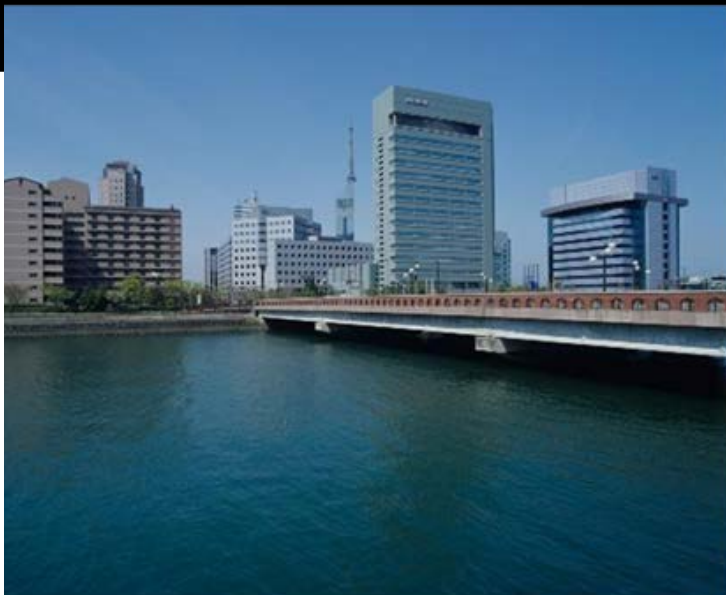
よかトピア橋 (3径間単純PCポステンT桁橋) 1989年に開催された「よかトピア」会場内のメインストリート
