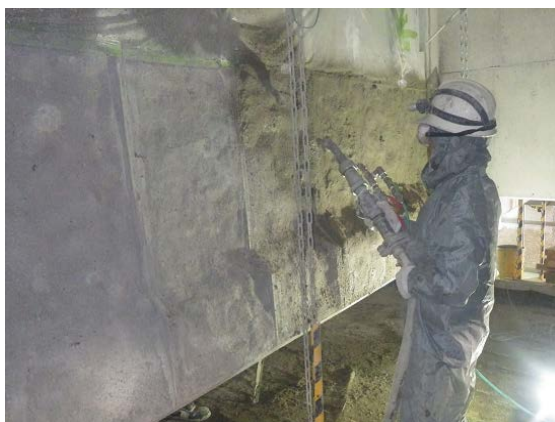
写真 3-2-6 断面修復状況（湿式吹付け）
