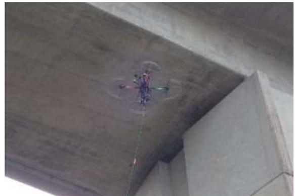
写真 5-2 ドローンを用いた近接目視点検
