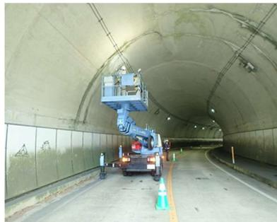
写真 2-1 トンネル点検状況
