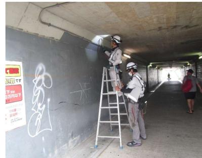
写真 2-2 地下横断施設点検状況
