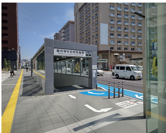
地下空間を利用した駐輪場 (櫛田神社前駅駐輪場)
