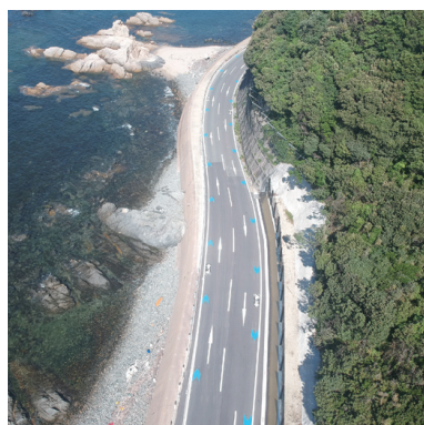
自転車通行空間整備
