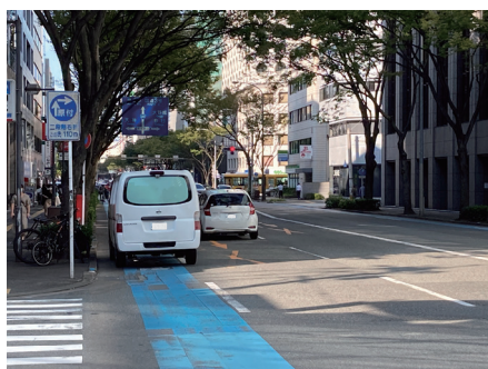
自転車通行空間上の違法駐車の状況
