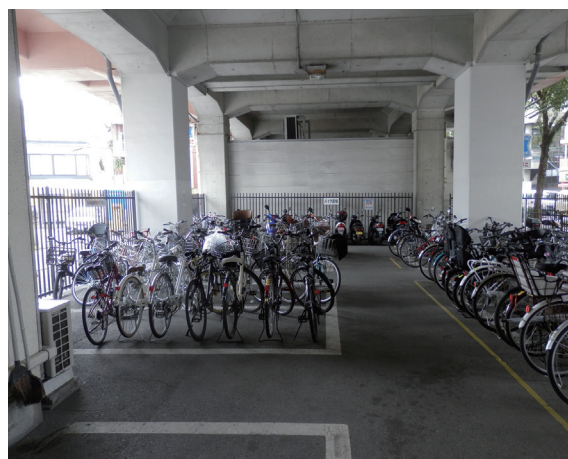
高架下を活用した駐輪場 (高宮駅高架下駐輪場)
