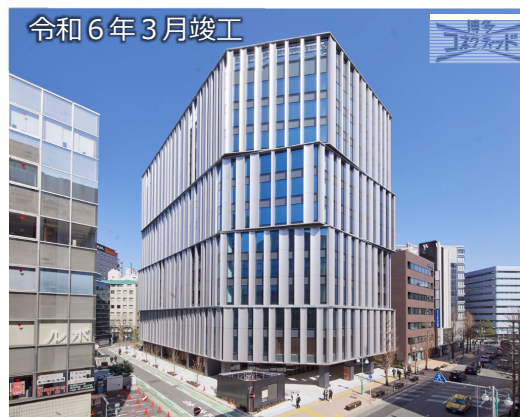
令和6年3月竣工 コネクトスクエア博多 〔 附置義務台数：76台 駐輪整備台数：92台 〕
