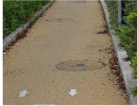
写真 3-3 マンホールの蓋に滑り止め加工している事例
