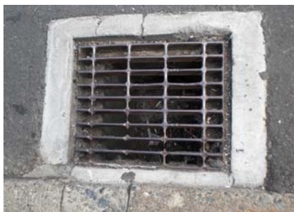
写真 3-4 既設のグレーチング蓋の格子間隔が広く腐食しており、格子間隔が狭いグレーチング蓋に取替えた事例
