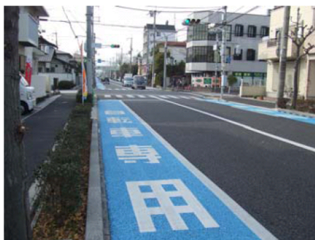
写真 3-1 街渠をエプロン幅の狭い平坦性の高いものに置き換えた事例
