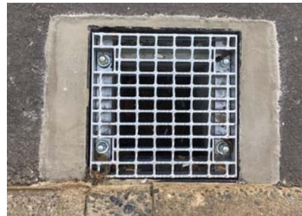
写真 3-4 既設のグレーチング蓋の格子間隔が広く腐食しており、格子間隔が狭いグレーチング蓋に取替えた事例
