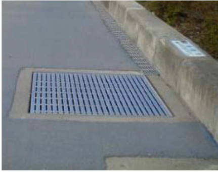
写真 3-2 グレーチング蓋の格子間隔を狭め、滑り止め加工している事例
