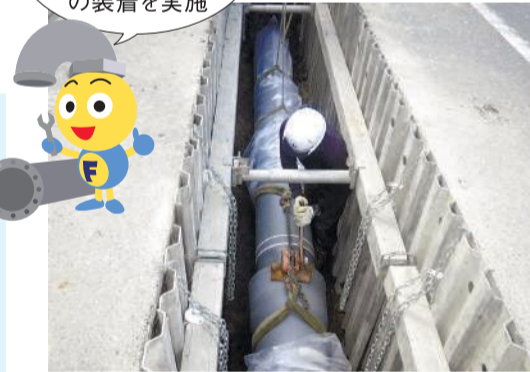
配水管取替え
