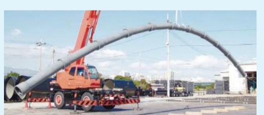
耐震管の吊上げ実験の様子 写真提供:一般社団法人日本ダクタイル鉄管協会
