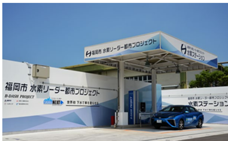
下水バイオガス由来水素ステーション
