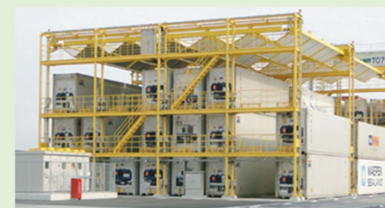
屋根付きRF施設 導入 (2010年)
