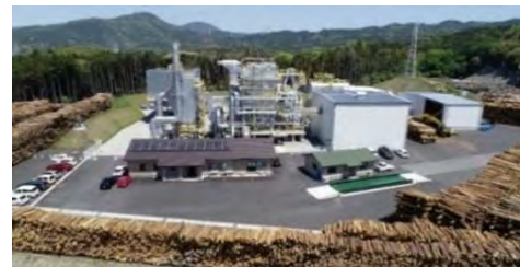
▲ ふくおか木質バイオマス発電所
