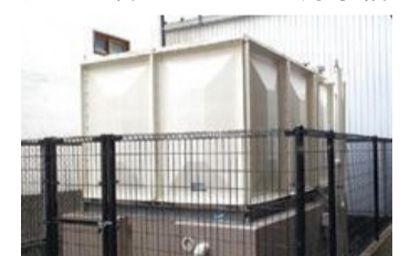
▲貯水槽周辺は清潔であり、ゴミ等が置かれていない
