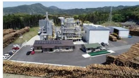
▲ ふくおか木質バイオマス発電所
