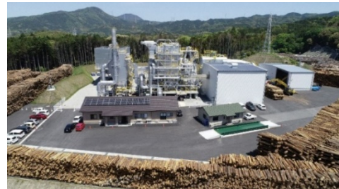
▲ ふくおか木質バイオマス発電所
