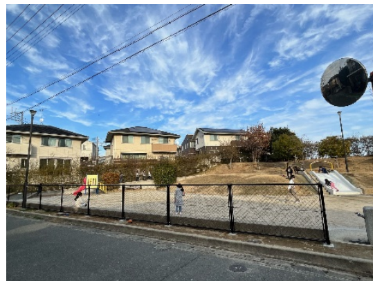
【フェンスが設置された 若久中公園】 （南区野間4丁目13-13）
