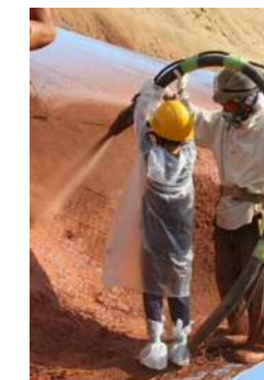
[実際の作業員によるソイルバズーカ体験]
