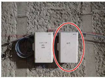
【遠隔臨場用の坑内Wi-Fiの設置（現場側）】
