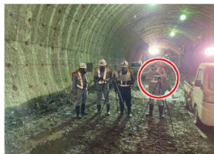
【会議用スピーカーの設置（現場側）】
