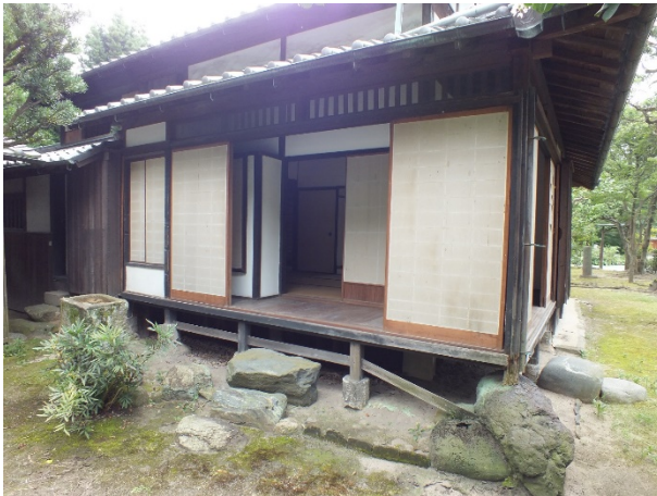
写真7 六畳北室 (縁が巡り、礎石に凝灰岩使用)
