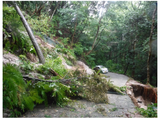
集中豪雨による林道の土砂災害
