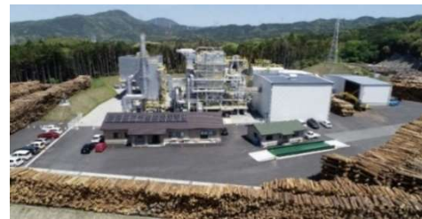
▲ ふくおか木質バイオマス発電所
