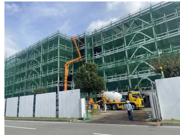
立体駐車場の様子（9/30時点）
