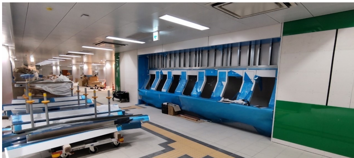
[内部の状況（駅務機器等）]
