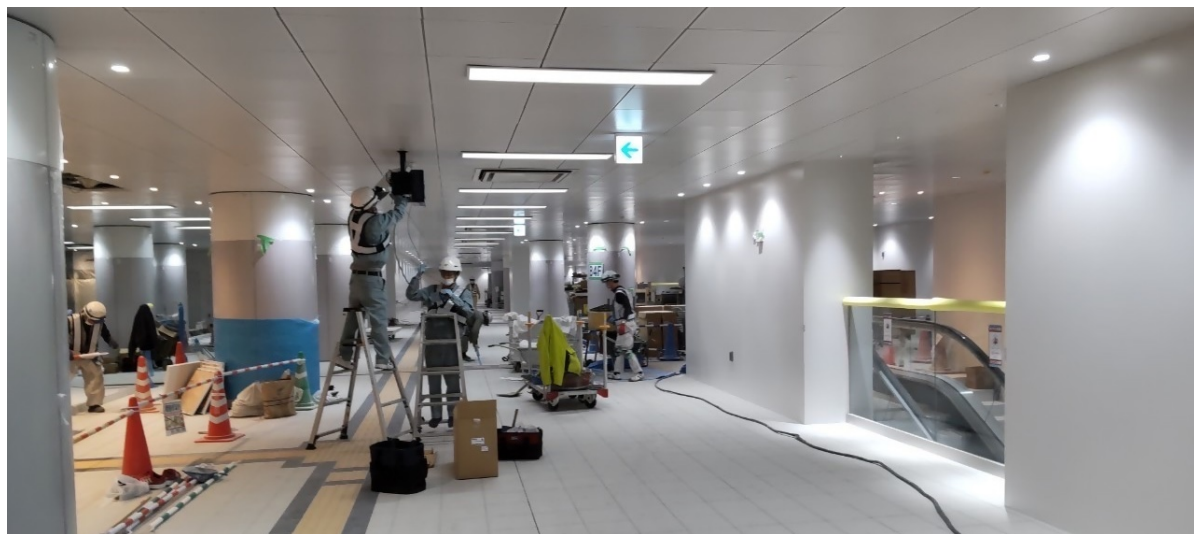
[内部の状況（コンコース）]
