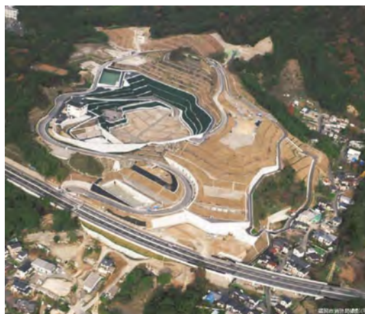
図2-10 福岡都市圏南部最終処分場
