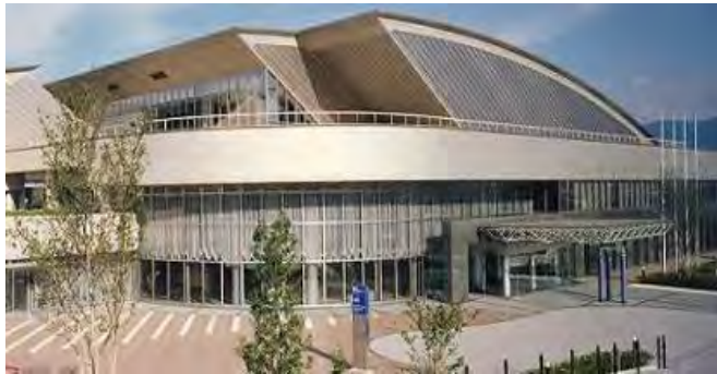
図3-7 総合西市民プール
