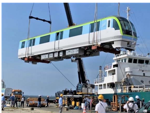
[陸揚げ作業状況]
