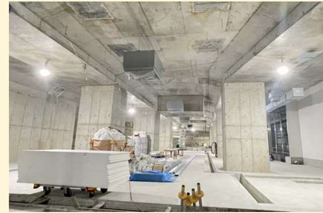
設備工事の進捗状況 (駅舎部: 地下5階)
