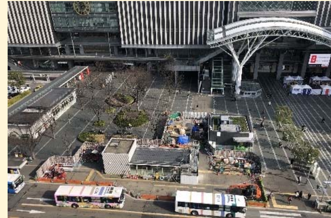
建築工事の進捗状況 (地上部)
