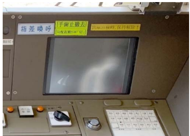
運転台表示装置
