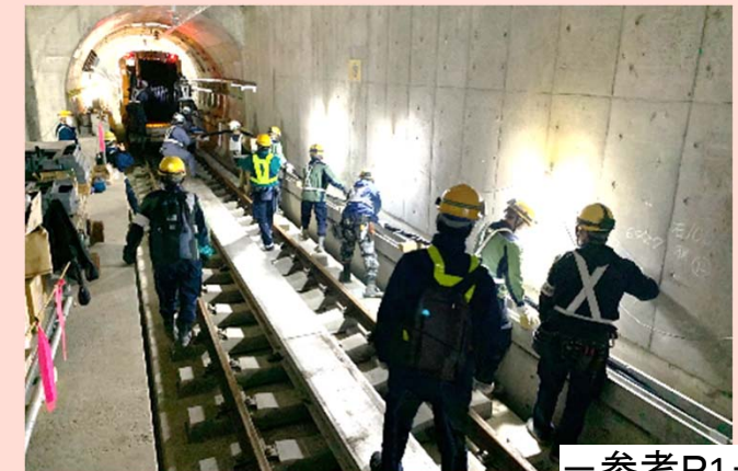
電線路工事の進捗状況 (櫛田神社前駅付近)
