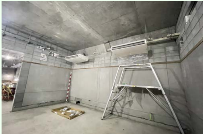
建築・設備工事の進捗状況 (地下駅舎部)
