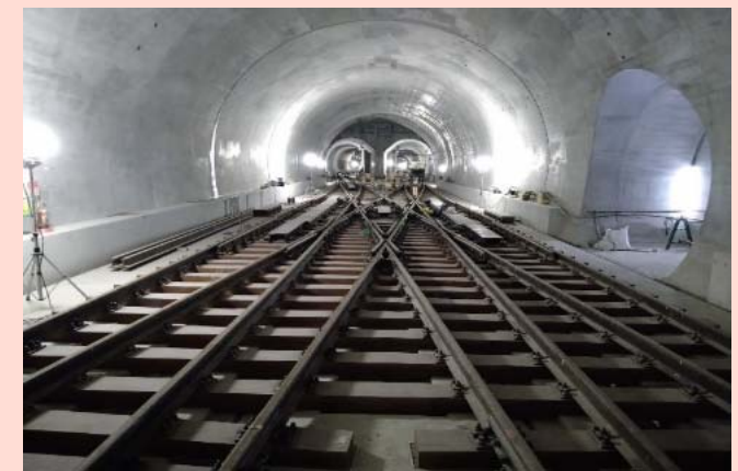
軌道工事の進捗状況 (博多駅付近)
