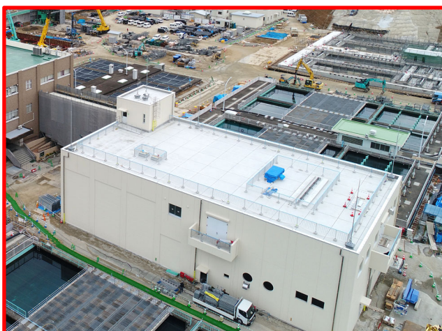
③ 薬注受電棟
