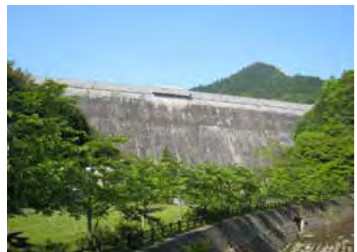
市指定有形文化財 曲渚水源地水道施設
