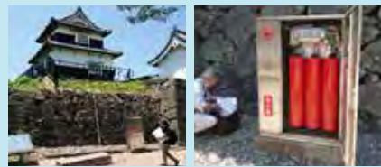
福岡城跡建造物 防火対策
