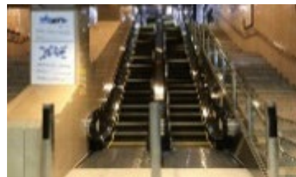
<地下鉄博多駅エスカレーター>
