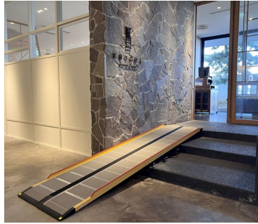
〈スロープの設置〉
