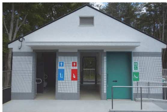
屋外トイレの整備
