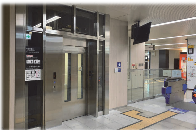
博多駅筑紫口エレベーター
