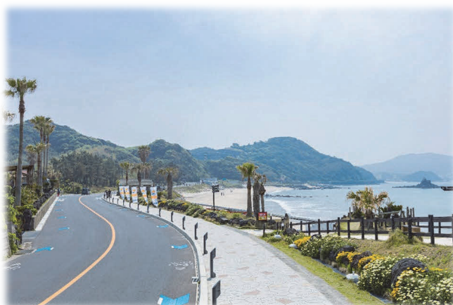
北崎地区の無電柱化された道路
