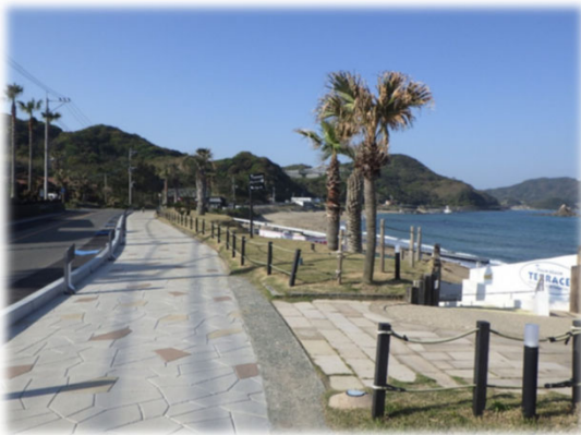
北崎地区の美装化された歩道
