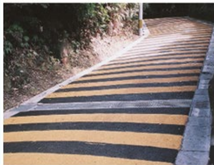
横断側溝の設置
