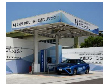
FCV（燃料電池自動車） 水素ステーション
