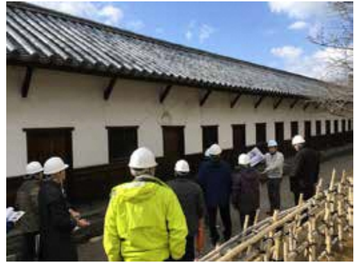
福岡城南丸多間櫓の修理
