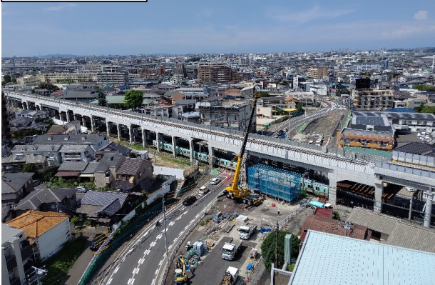
麦野跨線橋周辺
