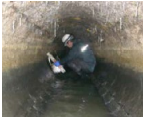
現状の管渠断面調査
