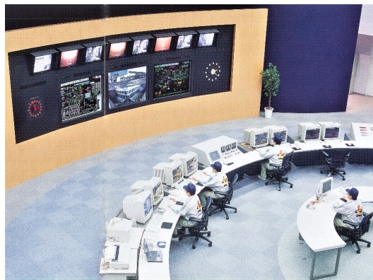
24時間体制の運転・監視の様子
