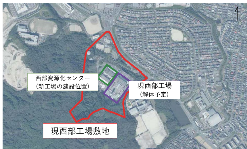
図3-2 新工場の建設位置(空中写真) 2
