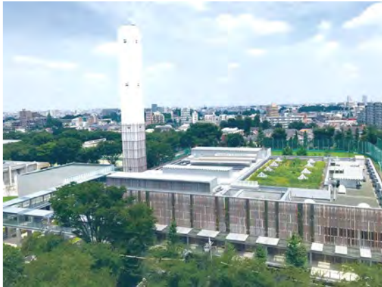
図1-2 武蔵野市 武蔵野クリーンセンター 1
