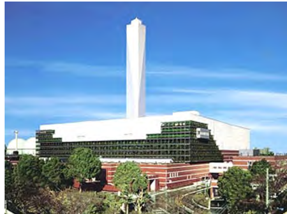
図1-3 東京都 板橋清掃工場 2
