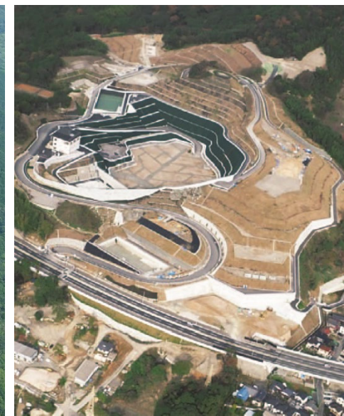
○福岡都市圏南部最終処分場
